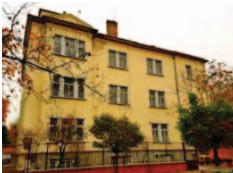
Budapest Benczúr utca 30 számú épület, aminek a felújítása idén elkezdődik
